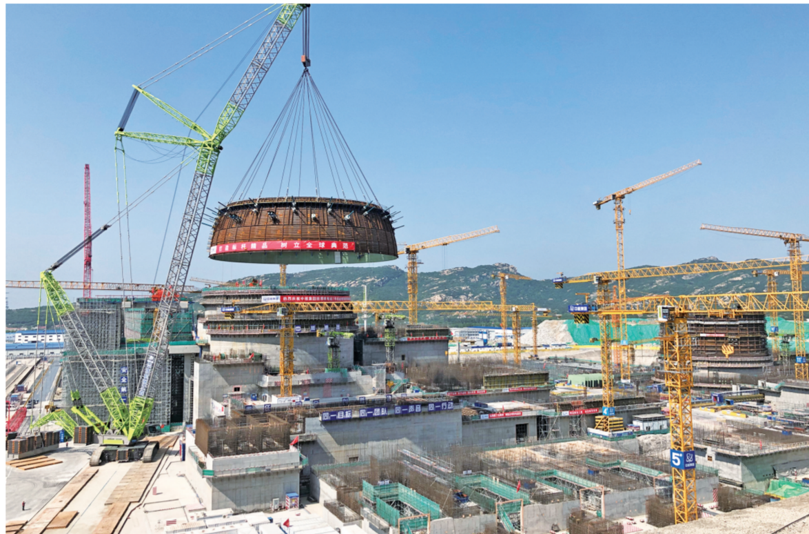
5月19日,田湾核电站7号机组穹顶球带成功吊装,标志着该机组从土建施工高峰全面转入安装阶段。据悉,田湾核电站7、8号机组核反应堆厂房为双壳结构,其中穹顶吊装分为球带和球冠两个部分。此次吊装的穹顶球带为环带形结构,上口、下口直径分别为36.522米、44米,高12.269米,总重达375.5吨。7、8号机组单机容量为126.5万千瓦,建成投产后田湾核电站总装机将超过900万千瓦。
