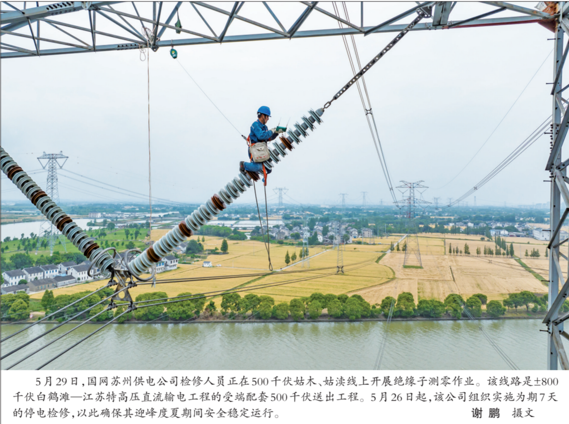
5月29日,国网苏州供电公司检修人员正在500千伏姑丈、姑溪线上开展绝缘子测零作业。该线路是±800千伏白鹤滩—江苏特高压直流输电工程的受端配套500千伏送出工程。5月26日起,该公司组织实施为期7天的停电检修,以此确保其迎峰度夏期间安全稳定运行。
