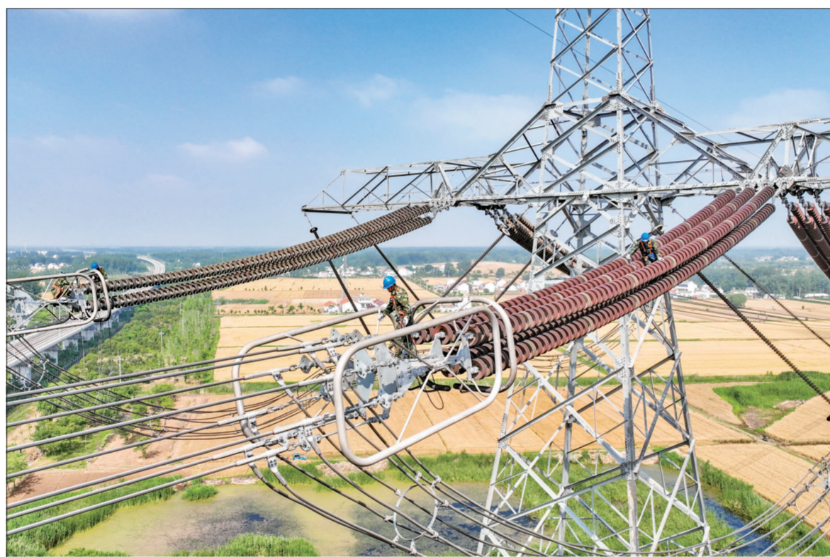
▲6月6日,跨越徐盐客运专线的±800千伏特高压直流输电线路检修现场,江苏省送变电有限公司员工正在距地面50米高空检查屏蔽环。5月24日起,该公司组织对该线路江苏段实施为期18天的全面检修,及时消除安全隐患,提高线路运行可靠性。史俊 摄文
