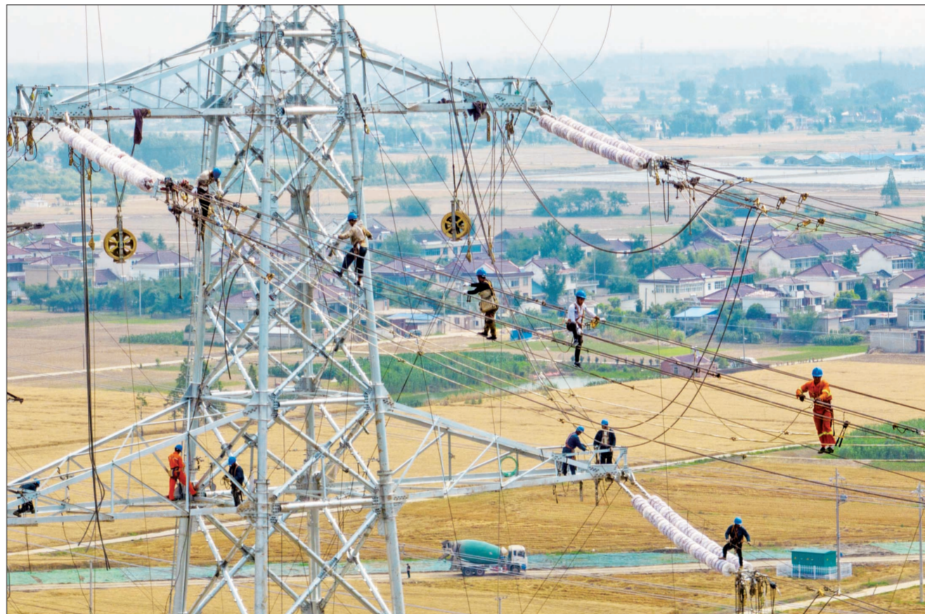
连日来，国网江苏省电力有限公司系统组织人员抢抓晴好天气，对北沿江高铁通道内的多条500千伏线路采取轮流停电方式进行迁移、升级改造，确保北沿江高铁建设稳步推进。图为6月8日施工人员正在泰州市姜堰区张甸镇高家庄地段的500千伏线路实施升级改造。 汤德宏 夏臻 撰文
