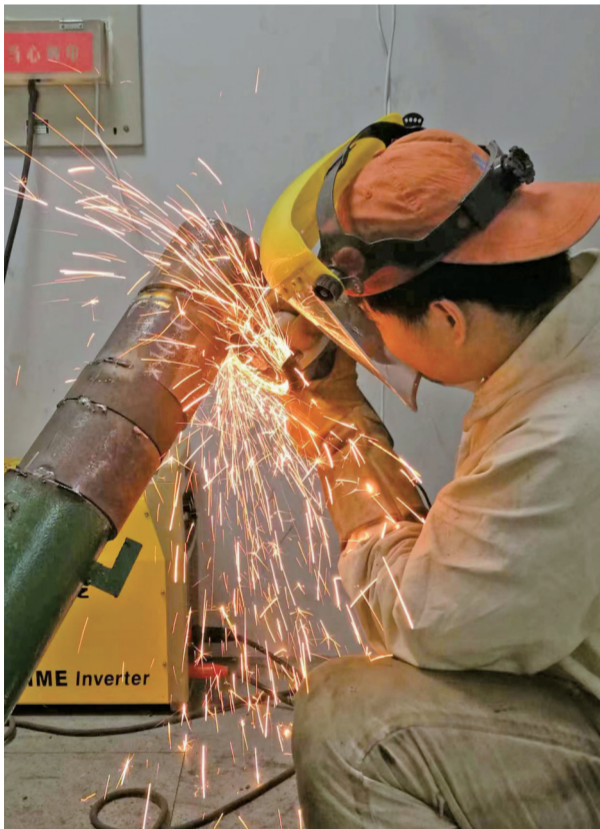
图为李京泽正在进行45度斜焊根层清理工作
