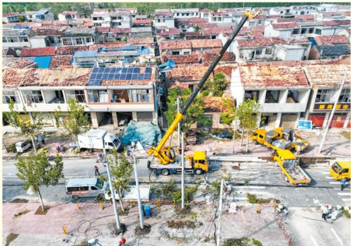
▲ 9月19日下午,宿迁市宿豫区大兴镇、市经开区南蔡乡局地陆续发生强龙卷风,造成6条35千伏和110千伏线路跳闸、14条10千伏线路发生故障。灾害发生后,国网宿迁供电公司第一时间成立现场抢修指挥部,组织400余名抢修人员、151辆各类抢修车辆,连夜展开抢修。至20日17时,所有受损线路已全部陆续恢复送电。图为9月20日抢修人员正在受损的10千伏大兴线下安装配电变压器。
