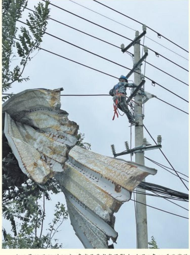
▲ 9月19日20时30分,阜宁县受龙卷风影响,全县5条10千伏线路跳闸,150个台区、2000余客户用电受到影响。国网阜宁县供电公司快速响应,至20日18时许,所有故障线路恢复正常供电。图为9月20日6时,抢修人员正在10千伏童营线沿线一基电杆上更换被树枝、铁皮棚砸坏的瓷瓶。
