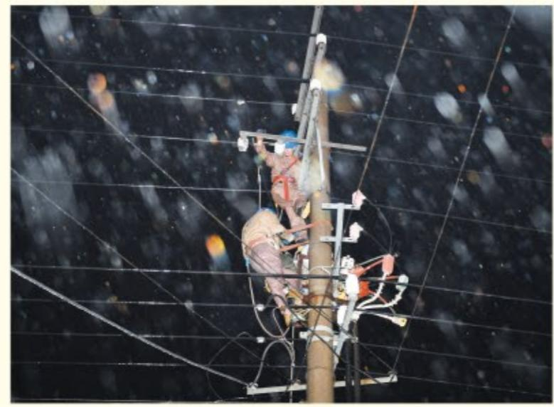
▲ 9月19日夜,涟水县普降大雨到暴雨,部分乡镇最大降水量超200毫米,并伴有短时8级以上大风,造成5条10千伏线路跳闸。国网涟水县供电公司迅速组织人员巡线,确认故障点后展开抢修。至20日3时许,所有故障线路抢修完毕恢复正常供电。图为该公司抢修人员正在该县朱码街道处理10千伏农机线11号电杆高压引线遭雷击断线故障。
