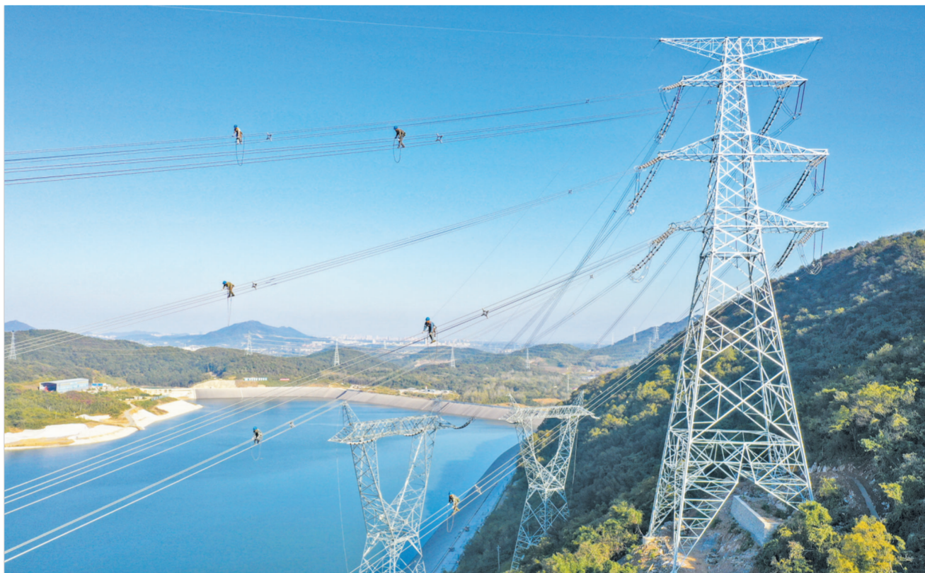
11月1日,句容抽水蓄能电站500千伏送出工程现场,江苏省送变电有限公司作业人员正在百米高空进行走线验收和消缺,确保工程零缺陷投运,为句容抽水蓄能电站2025年如期建成并网发挥好调峰等作用奠定基础。 史俊 摄
