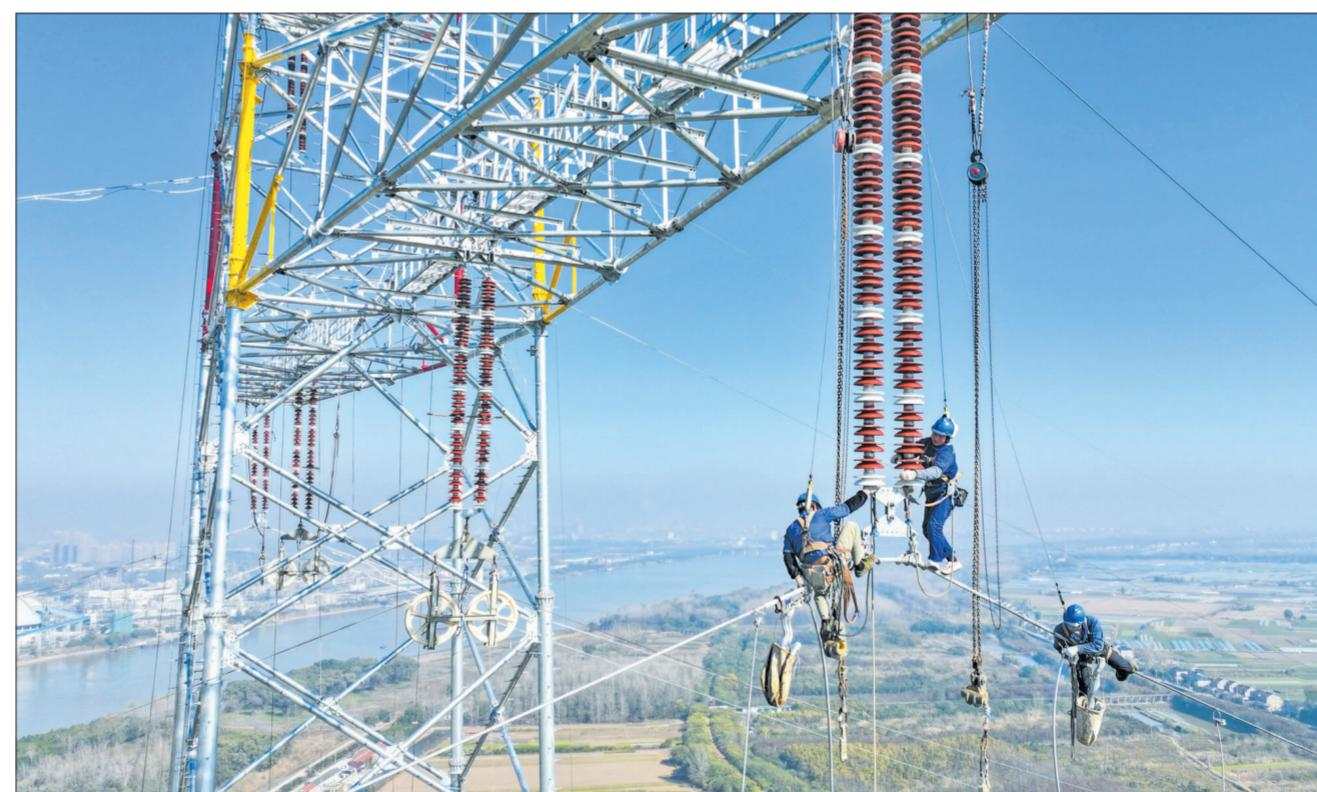
11月21日,江苏省送变电有限公司施工人员正在南京220千伏华晓线夹江跨越段南岸铁塔上安装附件。因该塔运行时间近50年,出现倾斜位移缺陷情况,国网南京供电公司决定在旧塔附近组立新塔并更换相关导线,以此保障线路安全运行。同时,该塔将由163.9米增至181.2米。史俊 摄文
