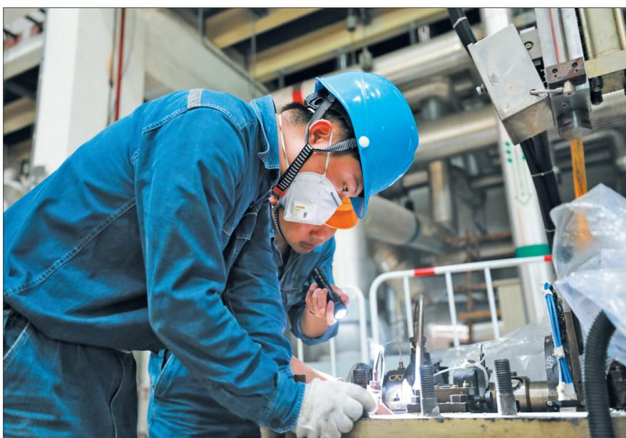
为应对今年首场寒潮,太仓港协鑫发电有限公司迅速反应、周密部署,落实落细防寒防冻及迎峰度冬各项措施,全力做好抗击雨雪冰冻灾害保供电工作。图为1月22日该公司热控人员正在检查小汽轮机安全监视及保护系统的测点。
