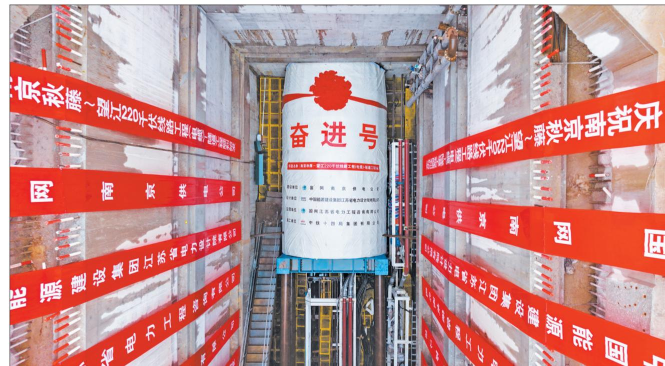
1月18日，南京220千伏永泰~赣江220千伏长距离海底电缆工程盾构机始发。此次施工应用新型承插式管片技术，能够有效提升成型隧道结构受力、防水性能和外观质量，降低后期运营难度和成本。该段盾构隧道全长约570米，埋深超过10米，预计4月初实现贯通。
