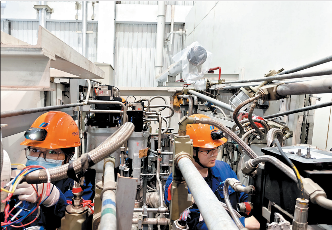
4月起,江苏华电扬州发电有限公司组织开展 强化本质安全 夯实保供基础 生产环节专项检查 坚持查找反思整改闭环,在夏季用电高峰来临前全面筑牢安全生产防线。图为该公司检修人员正在进行燃机FG小间燃料阀组信号线缆绝缘检查。
