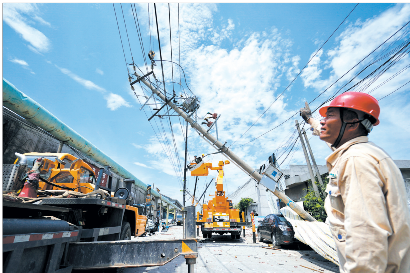
5月15日11时许，在位于苏州市吴江区盛泽镇荷花农贸市场附近，电力抢修人员正在对被龙卷风刮倒的10千伏珍珠线电杆紧急进行立杆修复作业。
