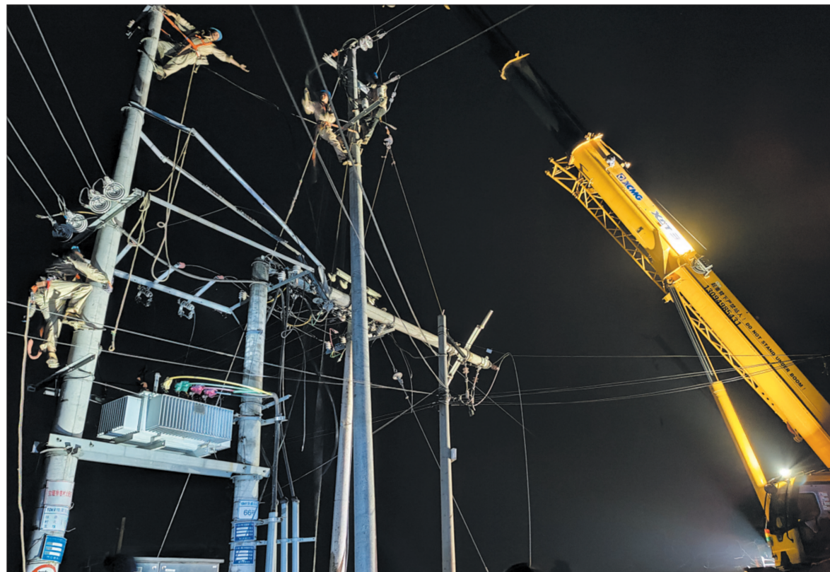
5月14日傍晚,镇江市丹徒区宝堰镇遭遇强对流雷暴天气袭击,造成10千伏华星线沿线10余基电杆倾斜,其中3基电杆倒塌时将附近1基电杆拦腰砸断,致使沿线包括徐巷渔业养殖基地和3个行政村在内的3000余户失电。国网镇江供电公司丹徒供电服务中心抢修人员待雨停后立即展开抢修,至15日0时20分恢复了线路正常供电。图为夜色中奋力抢修场景。王亮 陈泽洋 蔡颖 撰文
