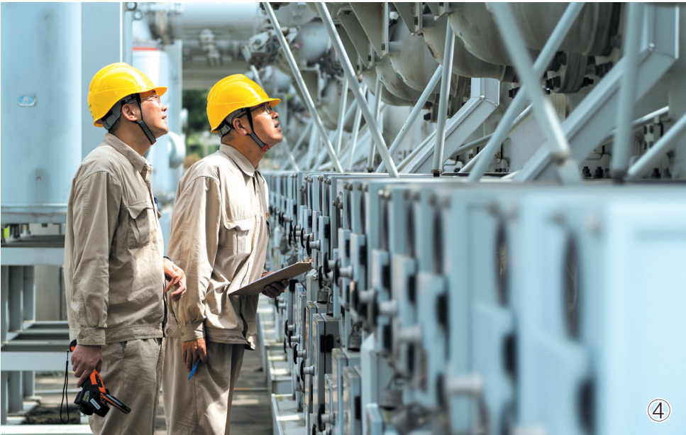
图①:7月8日,国网无锡供电公司对220千伏石塘湾变电站内新发现缺陷进行紧急处理,确保设备安全可靠运行。图为该公司员工正安装调试闸刀。
