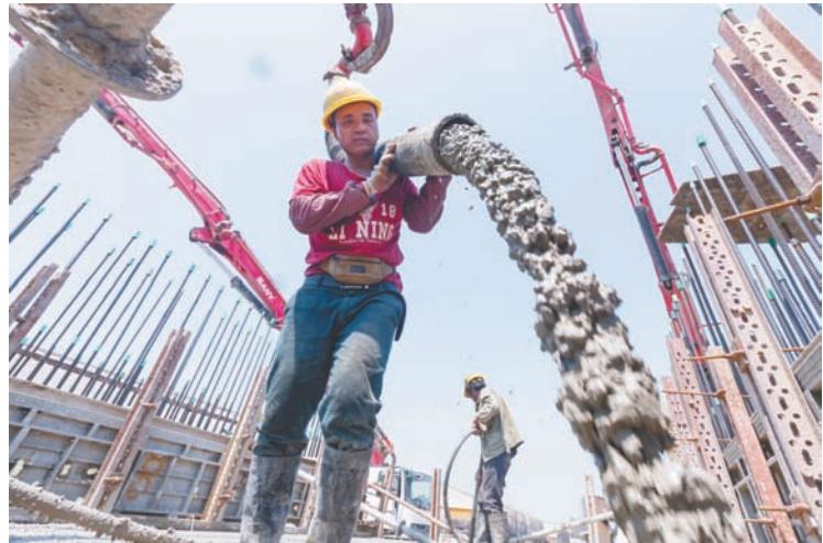
高温下浇筑底板混凝土
