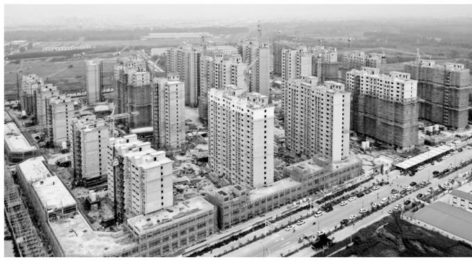
连日来,由中交一公局集团承建的淮安东荡苑安置小区项目,在严格落实疫情防控措施的同时,抓紧施工建设,确保项目按期顺利完成。据了解,该项目是淮安新城建设之路的重点工程之一。目前,26栋住宅楼主体、二次结构已全部完成,现正在进行内外墙抹灰、室内防水、屋面及安装工程等。
