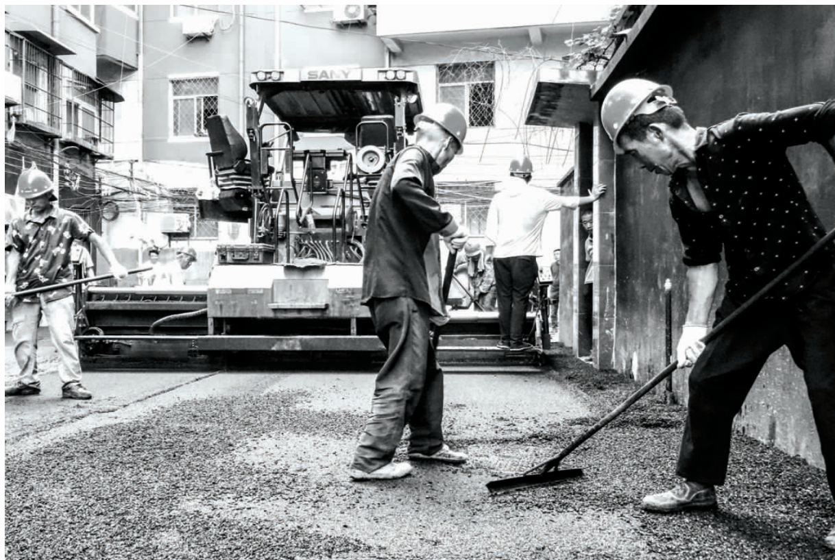
连日来，市人民医院家属院小区改造正在热火朝天施工，工人们冒着高温给道路铺设柏油。该小区建于九十年代初期，人员居住密度大，建筑比较老旧，环境、排水设施差。今年3月份，市住建局对该小区实施外立面粉刷、照明、给排水等改造，改善居民居住环境。该工程预计8月底完工。谢树立 彭贵志/摄
