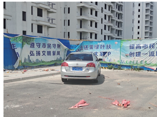
时间:7月1日 地点:金通紫薇园建筑工地东北角 存在问题:建筑工地围挡破损、未及时修理 责任单位:住建局
