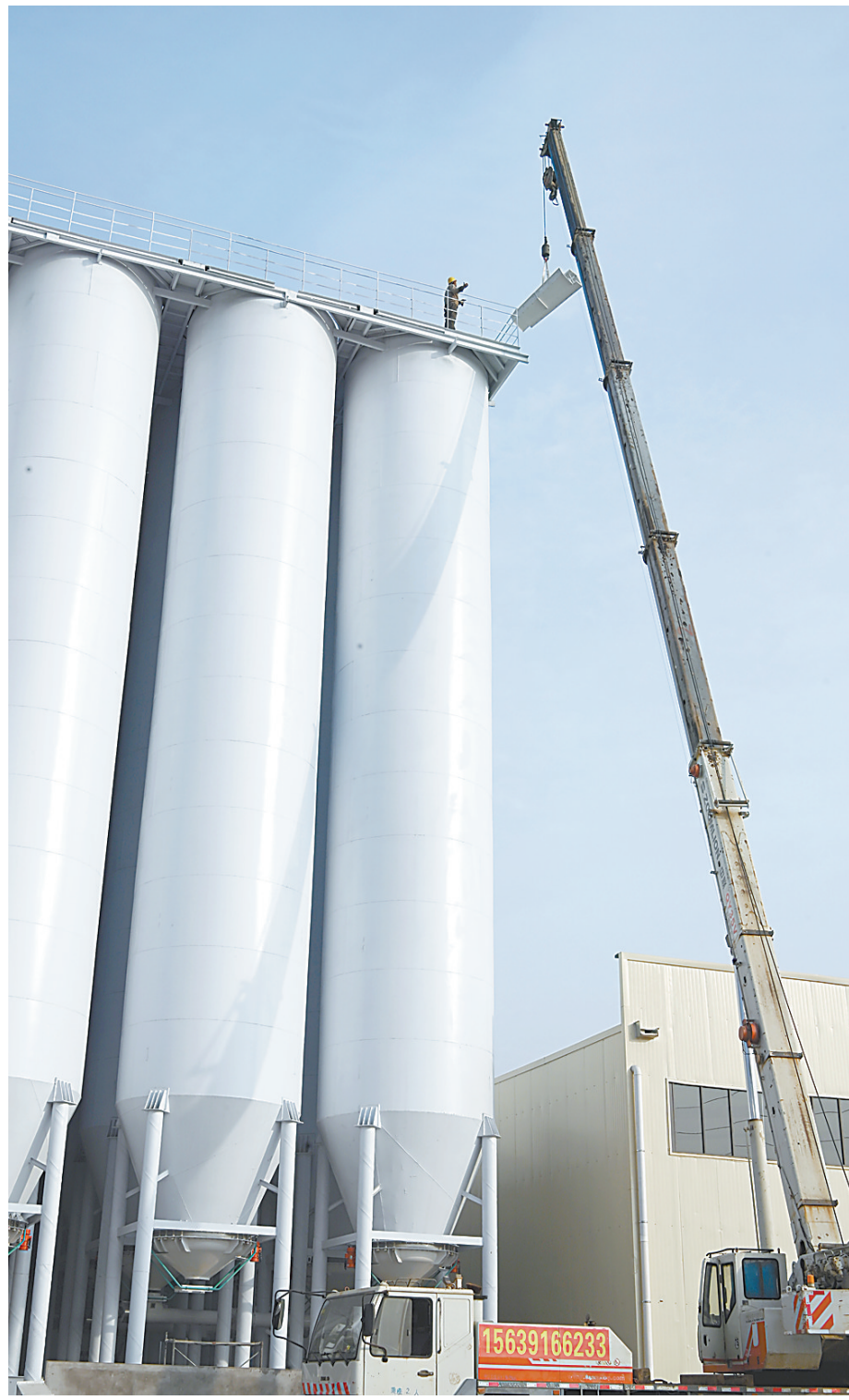
2月10日,位于孟州市河阳街道的河南汉永生物科技有限公司,年产60万吨小麦面粉精深加工项目正在加紧建设。“万人助万企”活动开展以来,河阳街道办事处积极帮助汉永生物科技有限公司解决生产、建设中遇到的各类问题,促进企业健康发展。该公司新建项目全部建成后,每年可生产小麦淀粉36万吨、谷粉10万吨,预计可实现年销售收入20亿元,年利税2亿元,增加就业岗位300人以上。
