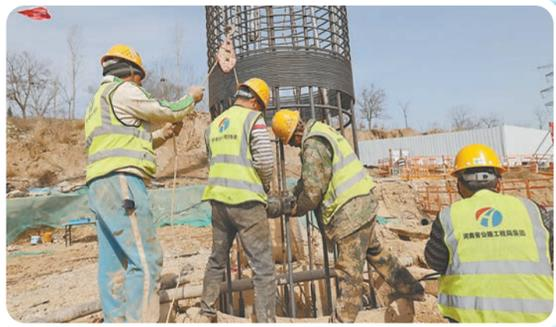
河南省公路工程局的建设者正在操作挤压机进行钢筋笼连接。 本报记者 段美如 摄
