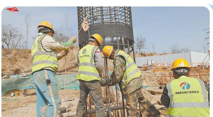
河南省公路工程局的建设者正在操作挤压机进行钢筋笼连接。
