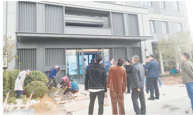
合作方负责人在项目工地视察。 筱 静 摄
