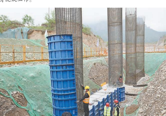
中交一公局集团沿太行高速焦济二标段云阳河大桥桥梁下部墩柱钢筋笼安装标准到位。
