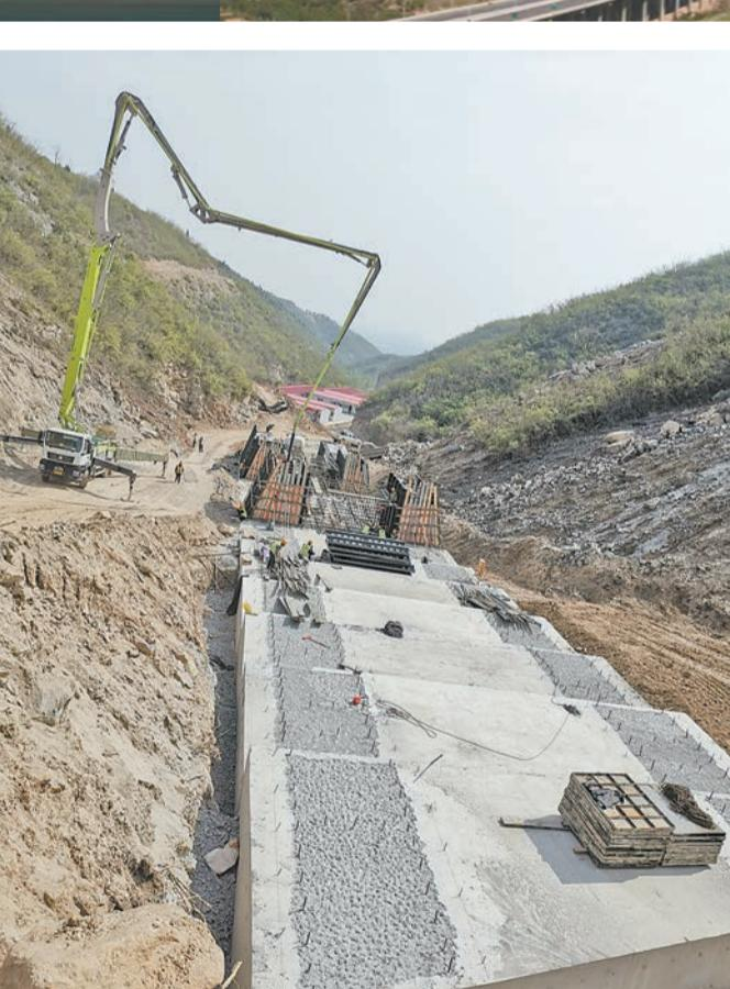
省公路工程局承建的沿太行一标二工区正在进行拱形涵洞墙身浇筑工作。
