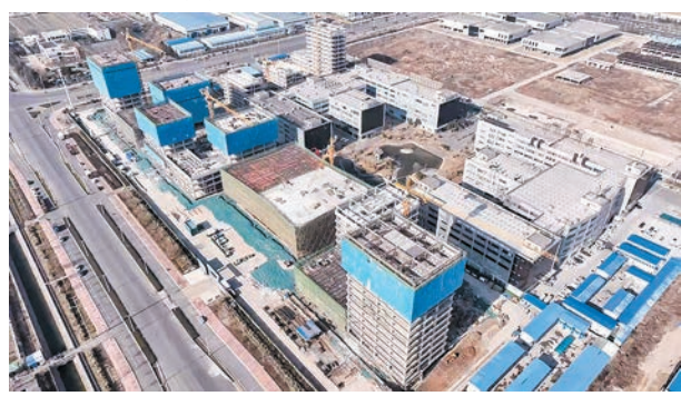
园区二期工程建设,快马加鞭。
