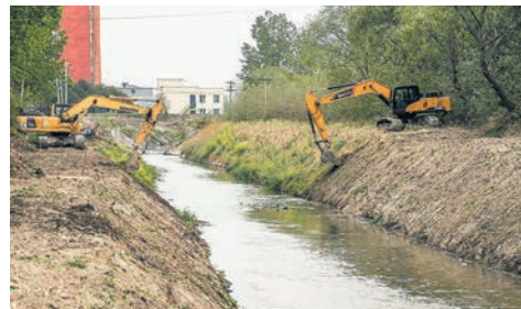
加快河道疏浚工程建设,确保泄洪畅通。
