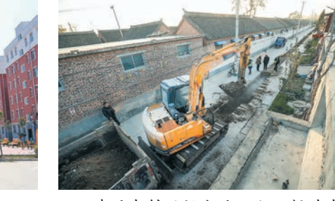
建设农村雨污分流工程,提升农民生活质量。
