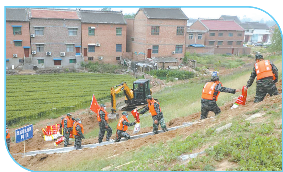
孟州市举行水库险情应急处置演练。图为坝坡塌坑填筑科目。本栏供图/各县(市、区)
