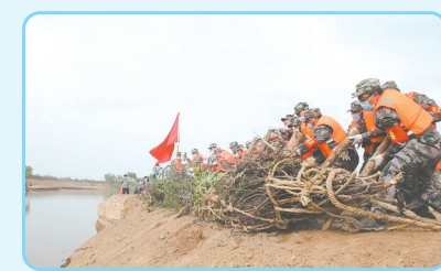
温县举行沁河堤防工程险情应急处置演练。图为捆抛柳石枕科目。
