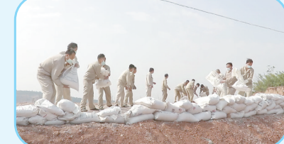
中站区举行佰利联堆场溃坝风险和避险转移应急演练。图为坝体加高加固科目。
