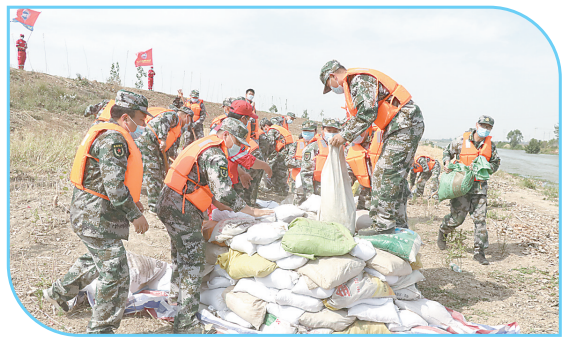
修武县举行大沙河堤防管涌抢险应急处置演练。图为推垒现场。
