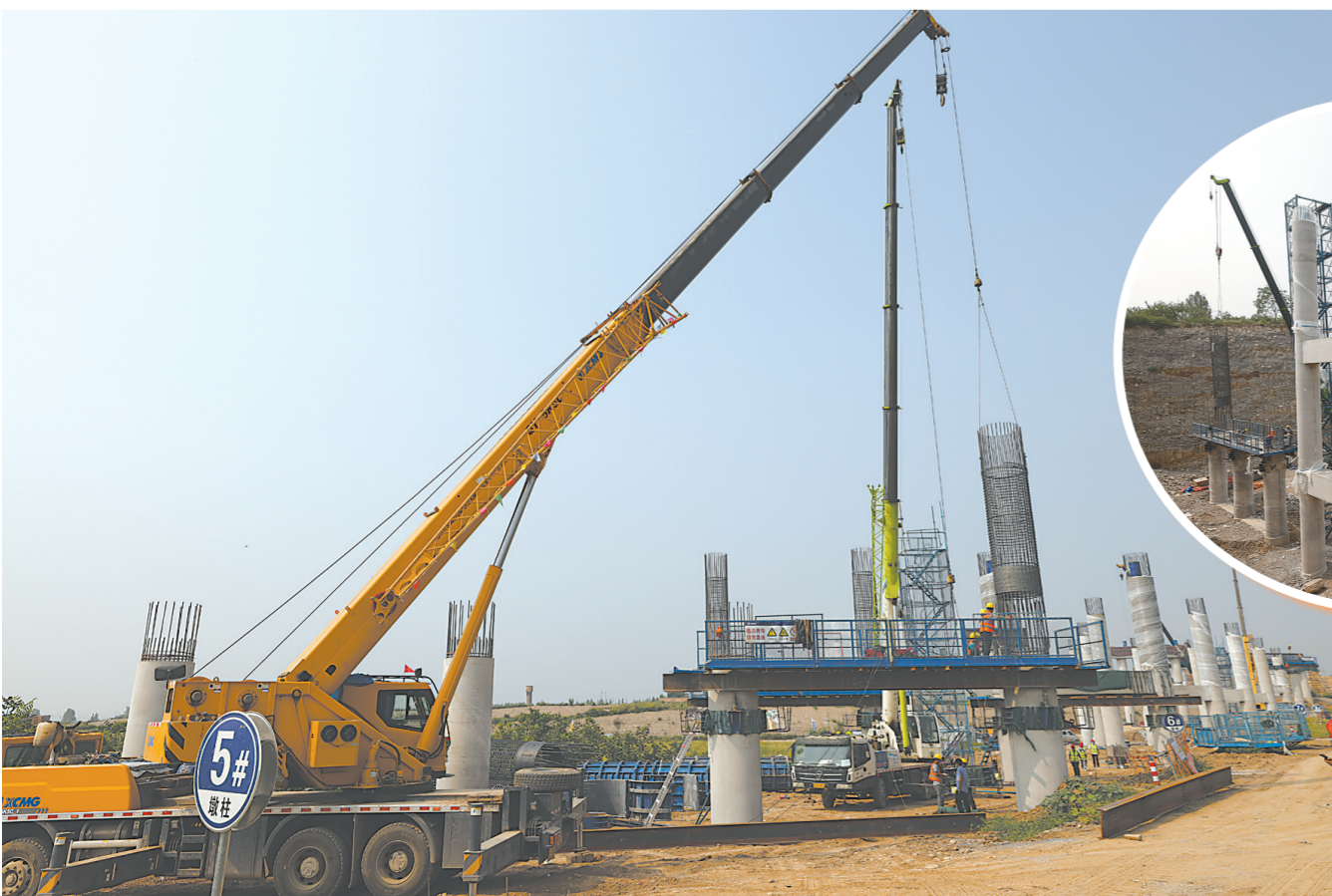
↑由河南省公路局承建的沿太行高速项目一标大河大桥已完成桩基124根,承台12个,立柱16根,盖梁3个。本报记者 段美如 摄
