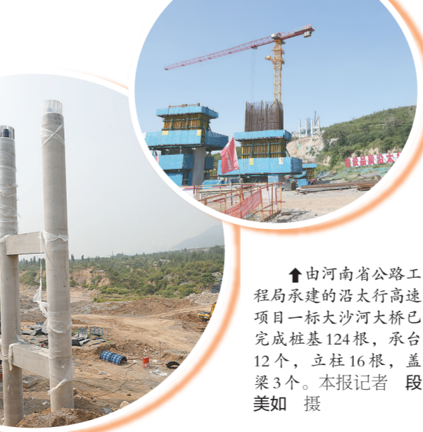
↑由河南省公路局承建的沿太行高速项目一标大河大桥已完成桩基124根,承台12个,立柱16根,盖梁3个。本报记者 段美如 摄
