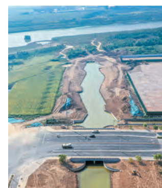
山阳河疏浚工程。
