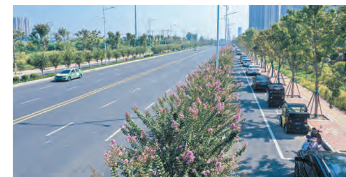
滨河路绿化工程。
