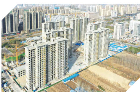
在建的滨河社区一期项目。 本报记者 刘金元 摄
