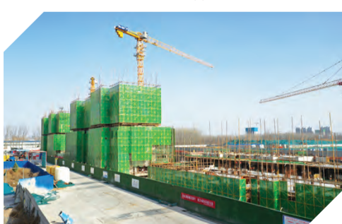
在建的鑫河社区二期项目。 本报记者 刘金元 摄
