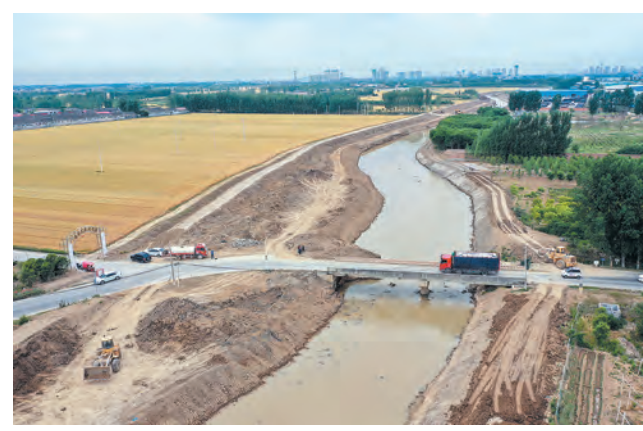
示范区新河疏浚应急度汛工程马坊镇孙村新河桥。本报记者 赵耀东 摄
