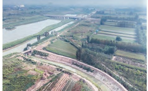
大沙河应急度汛工程。
