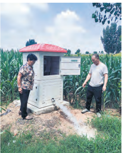
农田损毁修复工程。
