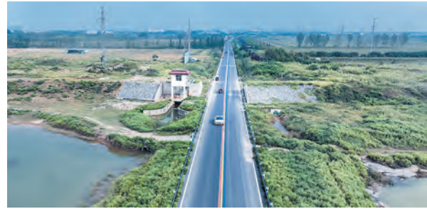
大沙河左岸马口应急度汛工程。
