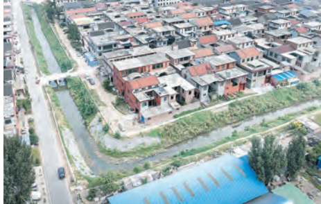
幸福河应急度汛工程。
