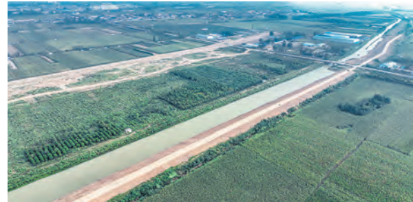
大沙河应急度汛工程。
