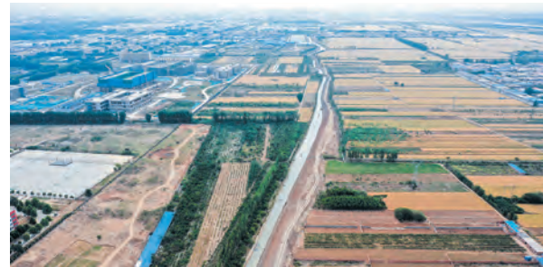
新河应急度汛工程。
