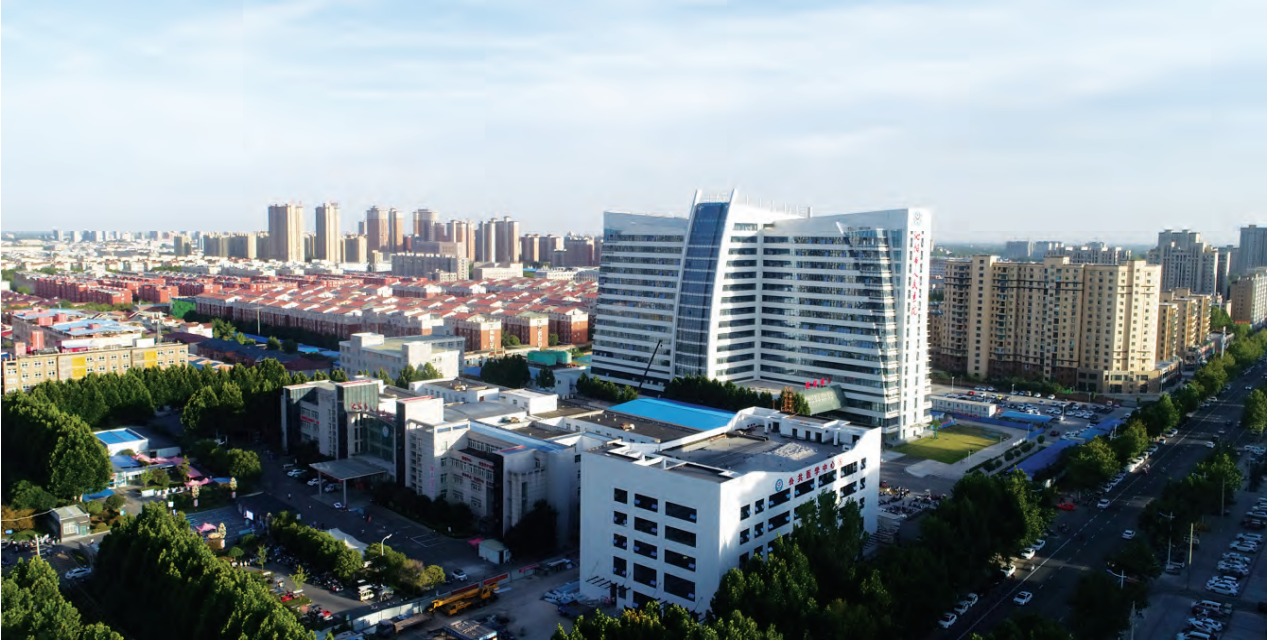
沁阳市人民医院病房楼拔地而起。
