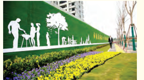
干净整洁的建筑工地围挡。
