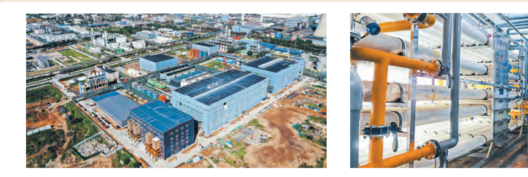
河南佰利新材料有限公司年产20万吨电池材料级磷酸铁项目建成投产达效。本报记者 刘金元 摄
