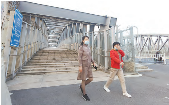
市民在政二街跨渠桥上经过。本报记者 高小豹 摄
