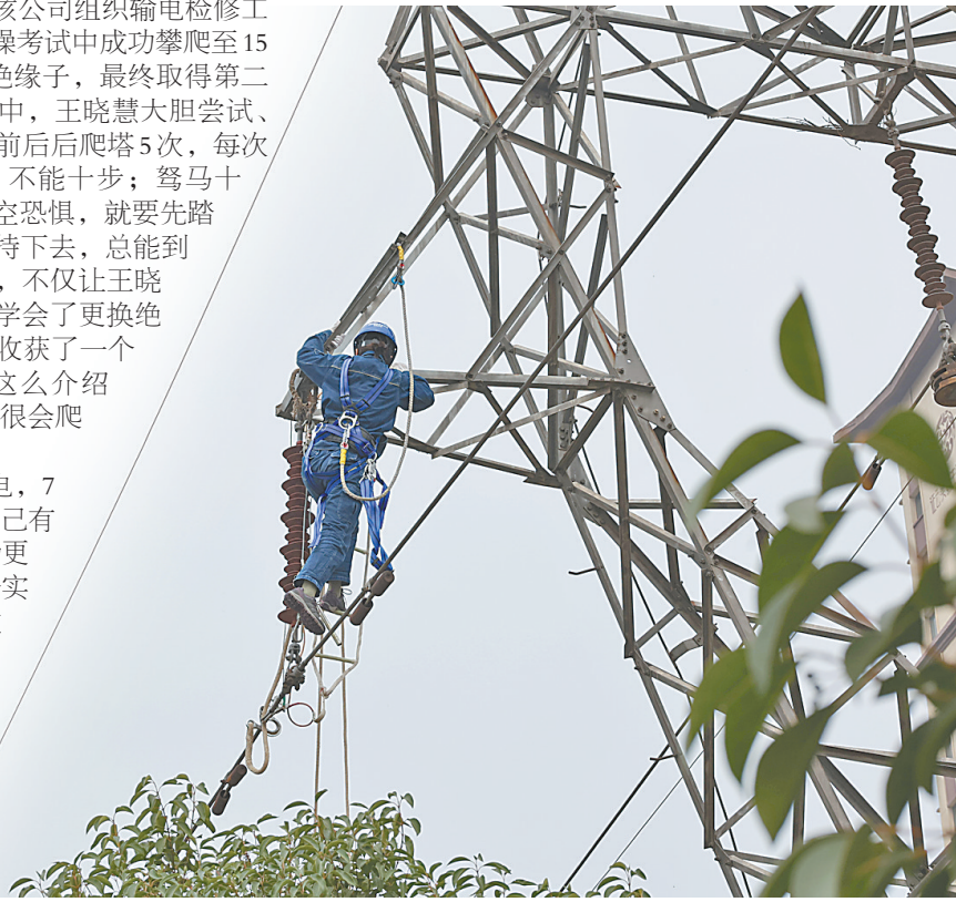
(本栏照片均为王晓慧爬上杆塔检修线路)
