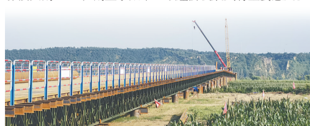
日前,焦平高速焦荣段黄河特大桥钢栈桥——钢栈桥顺利贯通,为黄河特大桥主体施工打通了“生命线”。
