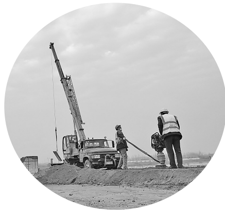
设施带炉渣回填压实。
