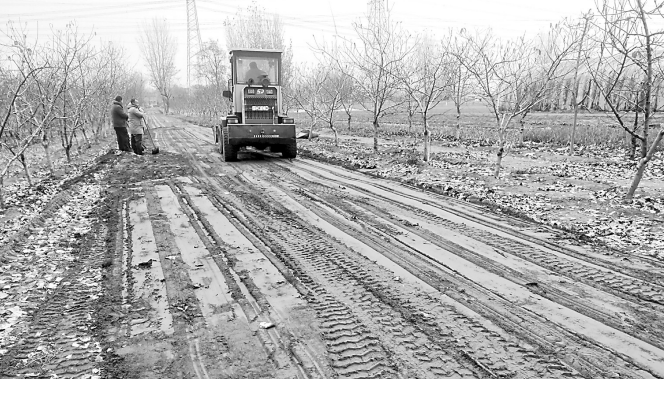
武陟县三阳乡不断加大农村基础设施建设力度,完善农村交通路网,满足群众生产生活需求。图为12月1日三阳乡中封村至李梧横村道路在进行路基平整。 本报记者 王龙卿 摄
