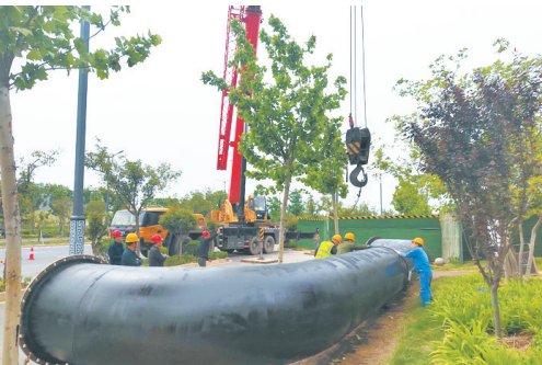
中原路供水管道“改道”迁建施工现场。
