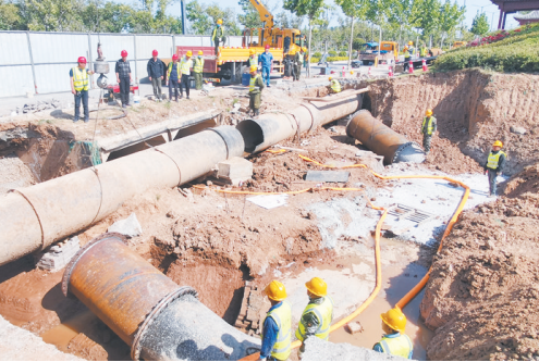
中原路供水管道“改道”迁建施工现场。
