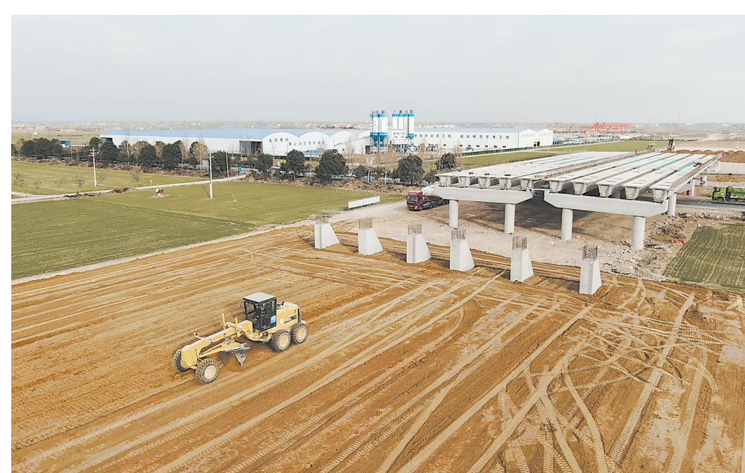
↑近日，由中交三公局承建的沿黄高速四标段跨S309大桥正在进行桥台背回填施工。
