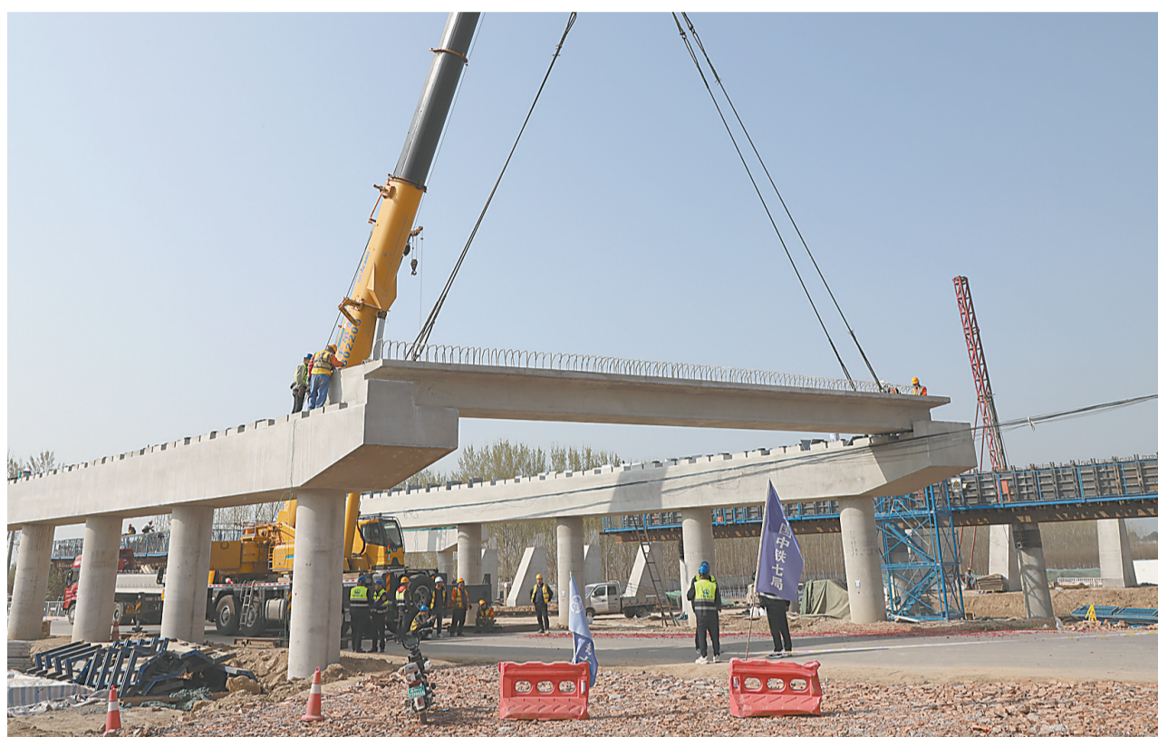
近日,由中铁七局承建的沿黄高速一标嘉应观服务区上跨004县道分离式立交桥首片16米预制空心板梁成功架设,拉开了桥梁工程上部结构施工的序幕。段玉明 摄
