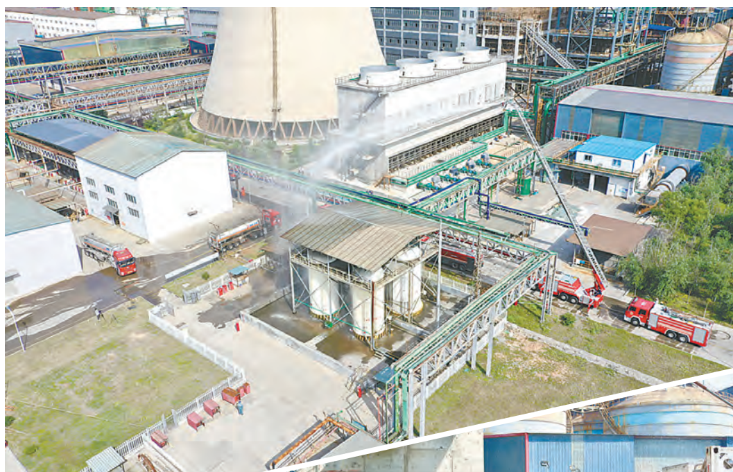
消防救援人员在使用高喷车对甲苯罐区喷水降温。
