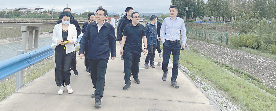
5月27日上午,市水利局、市南水北调中心领导带领相关科室负责人,冒雨到小官庄排水渡槽等防汛隐患风险点,检查督导隐患整改和防汛应急预案落实情况。
