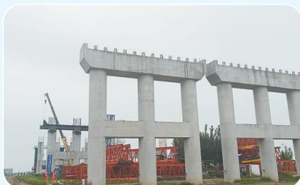
截至9月3日,由河南省公路局承建的焦平高速焦作段四标黄河特大桥内引桥288根桩基全部完成。
