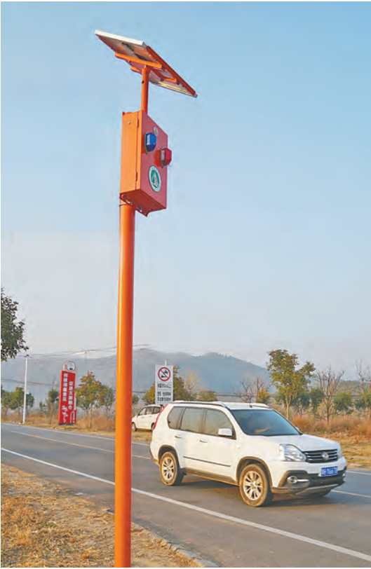
红外光线感知电子语音提示杆成为森林防火好帮手。（本版照片除署名外均为本报记者李晓军摄）
