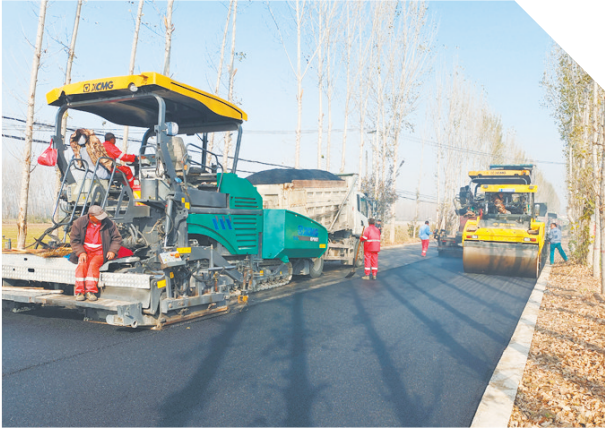
公路铺筑施工忙。
