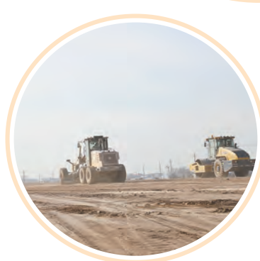
↑2月18日，焦平高速二标郭庄枢纽互通南路段施工现场，推土机在进行路基施工。 段玉明 摄
