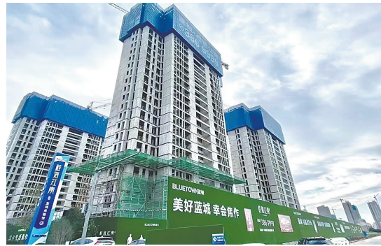
施工现场。 筱静 摄
