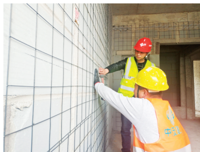
工程技术人员指导工人进行墙面挂网。
