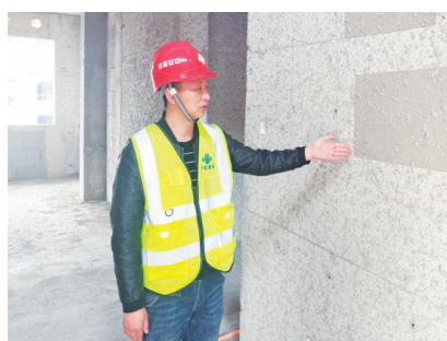
精心施工，及时对有瑕疵的墙面进行修整装饰。
