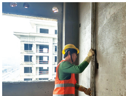
施工人员正在用尺杆检查墙体平整度。
